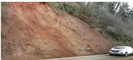
زیربُری دامنه برای ساخت جاده و وقوع لغزش
