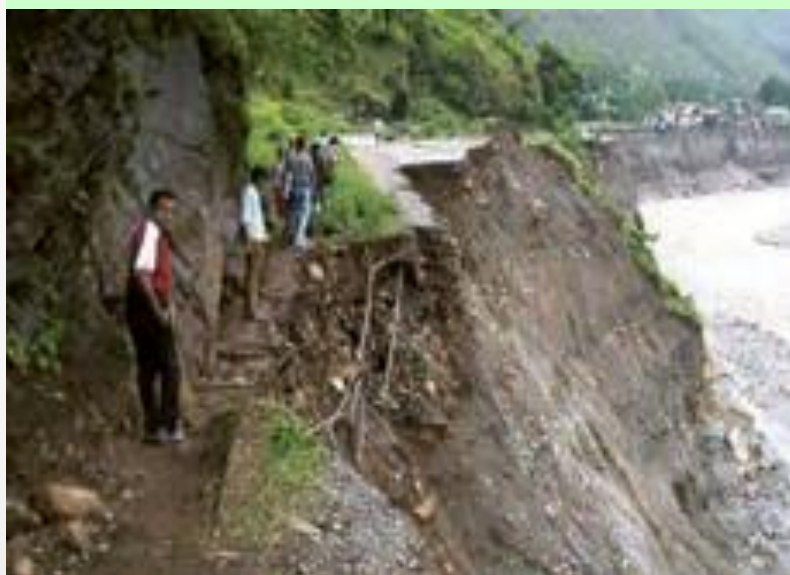
لغزش در اثر زیربری رودخانه در هند
